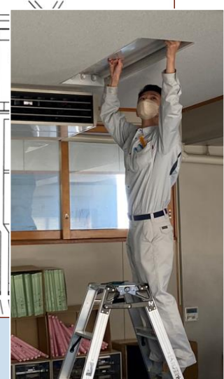
作業は【第二種電気工事士】の有資格者が行っています。
